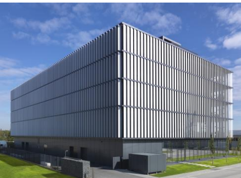
Bild 3: CUBE Headquarter in modernem, lichtdurchflutetem Gebäudekomplex (Quelle: Richie Mueller)
